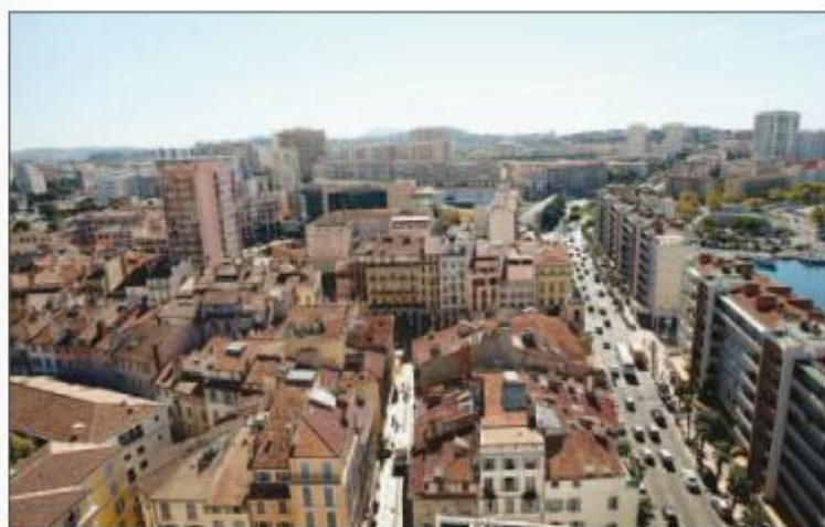
Les élus ont voté une prolongation du plan de rénovation urbaine du centre ancien et alloué 625 000 euros au financement des travaux. (Photo R. Bl.)
